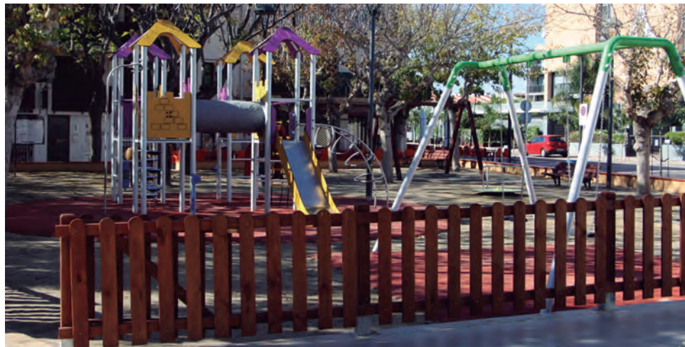
Instal·lacions del nou parc infantil. / Foto: A. J.
